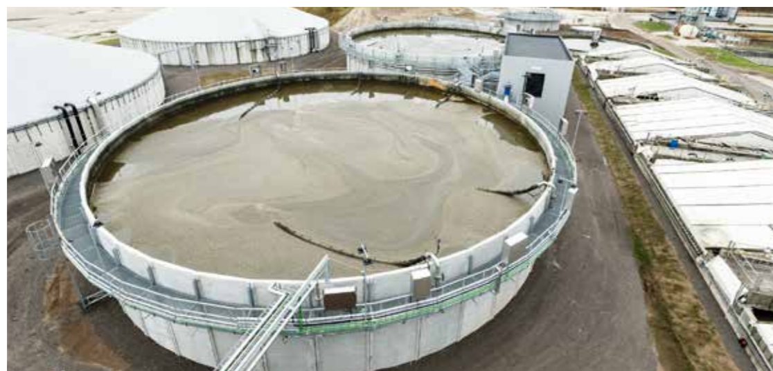
På det biologiske rensningsanlæg på Stigsnæs, som er det største kommercielle anlæg af den type i Norden, måler vi vægten af de skadelige stoffer, vi opsamler og fjerner, så vi kender den præcise kvalitet af det vand, vi leder ud.
